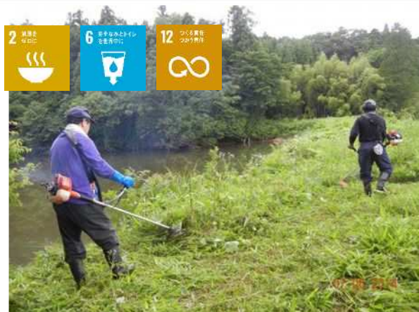
ため池堤体の草刈り
