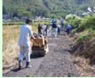
未舗装農道の舗装
