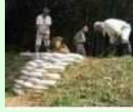
漏水箇所の補修
