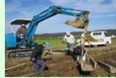
コンクリート水路の更新
