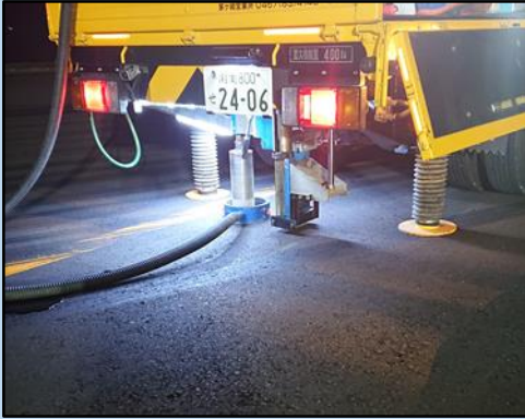
① テストボーリングの状況 （埋設部の中心位置を確認）
