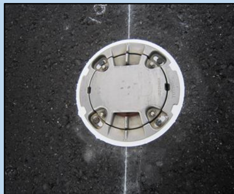
⑤ 灯器設置完了
