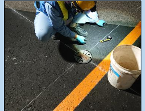
⑤ 灯器設置完了 （この後、樹脂注入作業）
