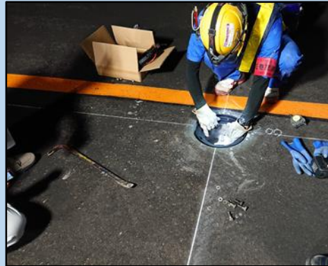
⑤ 灯器設置状況
