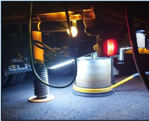
① コアカッターによる削孔(1) (事前にテストボーリング実施)
