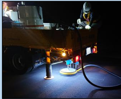
② コアカッターによる削孔(2)
