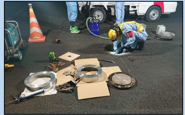
③ 削孔部の清掃状況及び使用材料
