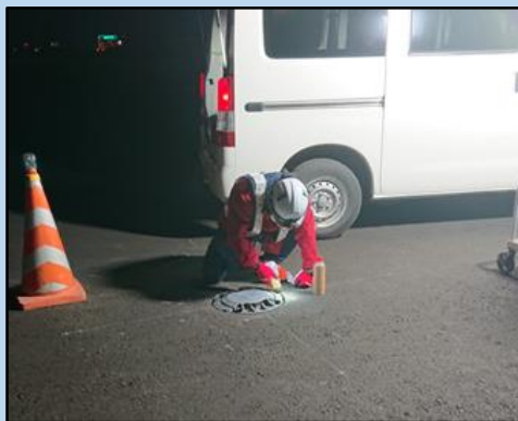
④ 灯火設置後の樹脂注入 (孔と灯器の隙間に注入)
