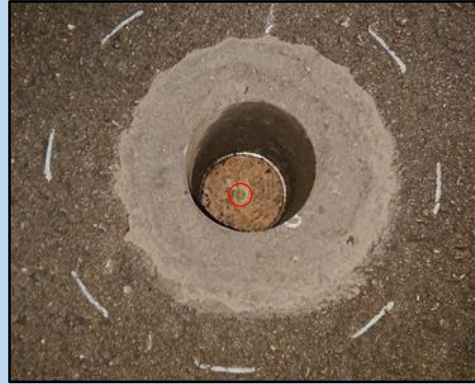
② 中心を確認し削孔位置を作図 （保護板の○部分が中心位置）
