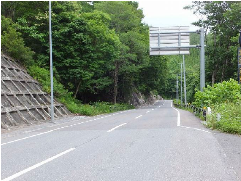
【子飼沢トンネルから東のカーブが続く狭隘区間】
