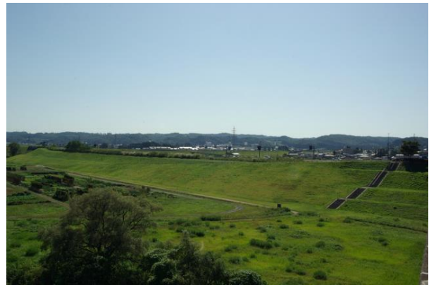
高館橋から南西方向
