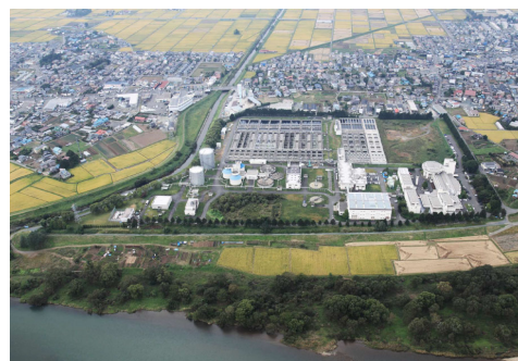
都南浄化センター
