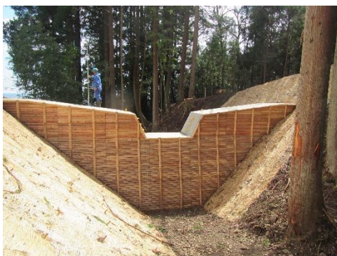
治山工事における木材利用 (木製残存型枠)
