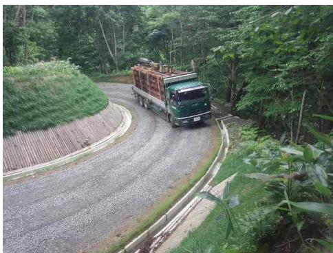
素材の搬出に利用される林道
