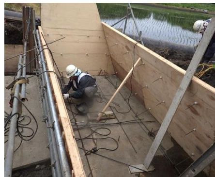
道路工事における木材利用 (型枠)
