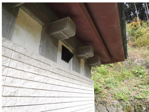
庫内の空気循環のための換気口設置
