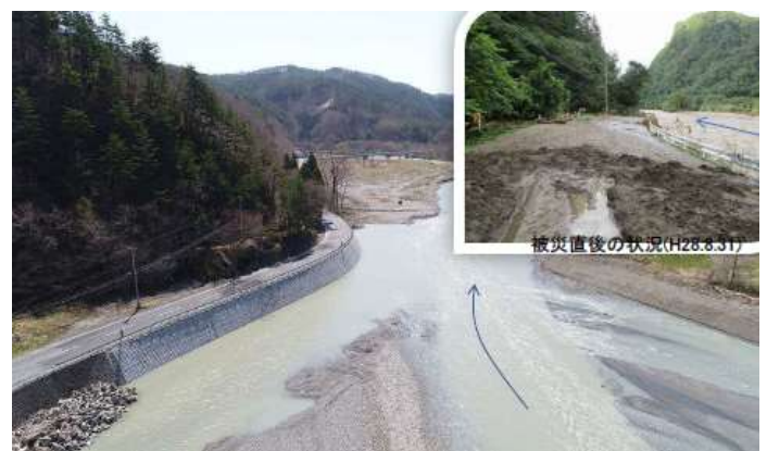
国道 455 号上地区災害復旧工事（H30.4）
