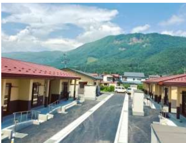
災害公営住宅（三本松東団地）（R元.8）
