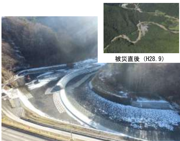
小本川河川改修工事（流木捕捉工）（R4.12）
