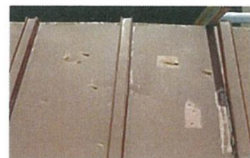
【りんどう棟の屋根(修繕前)】
