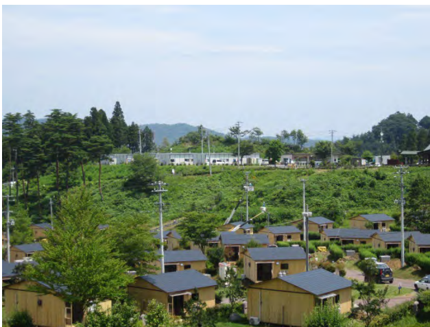
写真 3 木造戸建て型の仮設住宅（陸前高田市）
