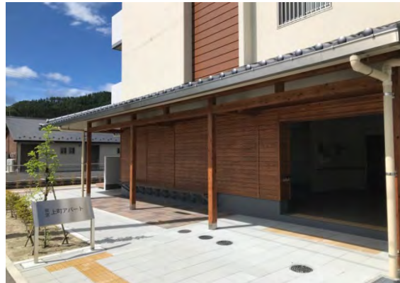
エントランス付近
