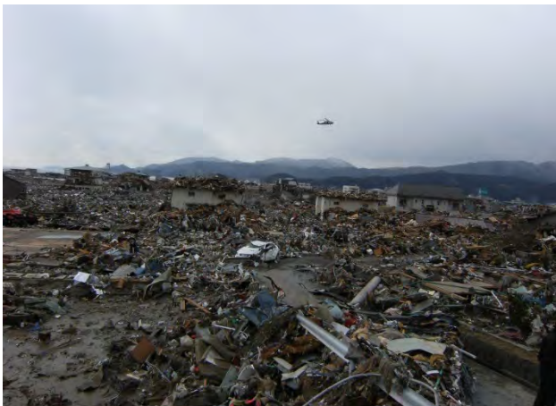
写真1 陸前高田市内の被災状況
