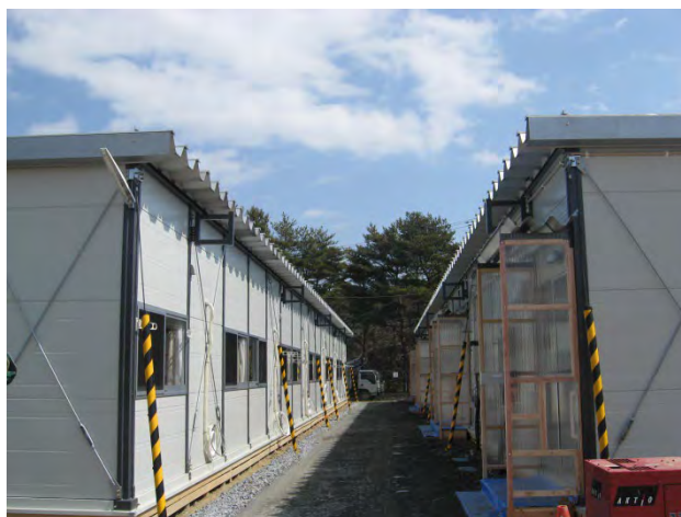
写真2 プレハブ型の仮設住宅（陸前高田市）
