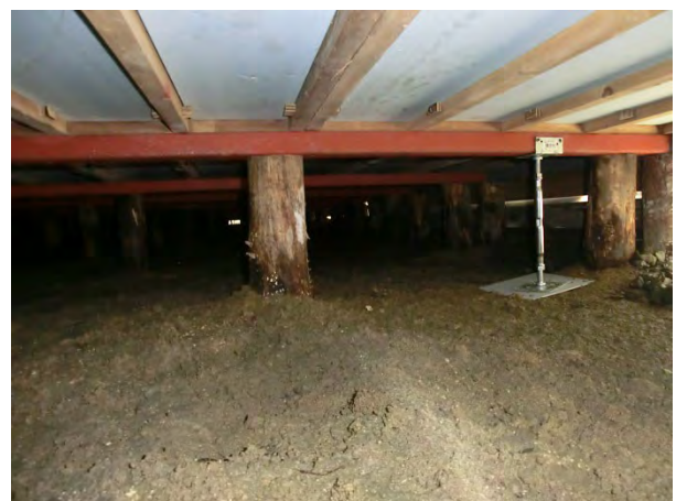
写真 4 仮設住宅の鋼製床束による補強
