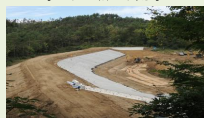
【ため池の対策工事状況】
