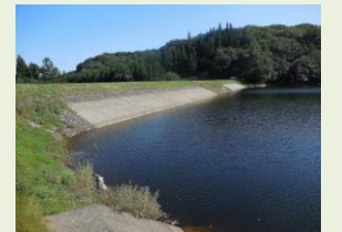
【対策が必要なため池】
