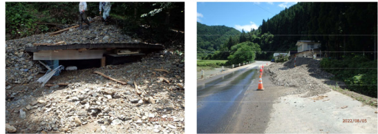
土石流が小屋を飲み込む被害が発生した。
