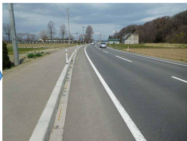
道路改良が完了した区間
