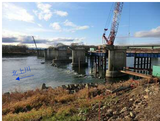
解体撤去中の旧小谷木橋
