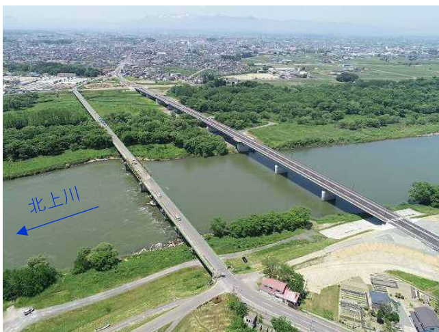
解体撤去前の旧小谷木橋（左）と新小谷木橋（右）
