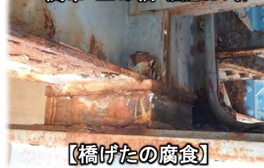
一関市 上の橋 (国道284号)
