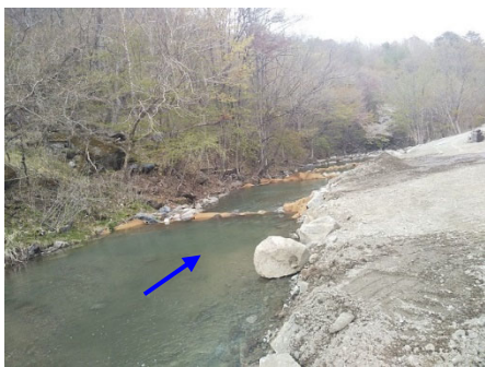
沈砂池の状況
