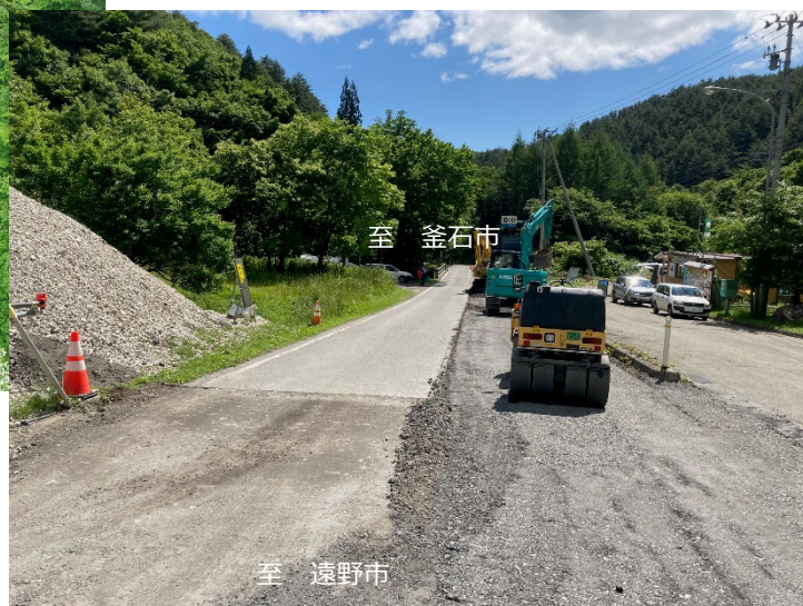
舗装の剥取状況
