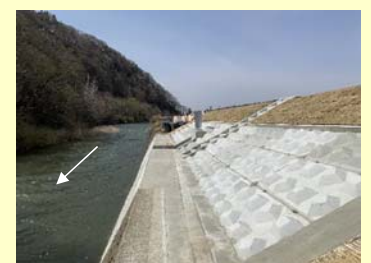
熊原川 橋ノ下地区 H30実施状況：排水樋門・築堤
