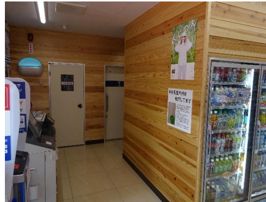
内装への県産木材の利用
