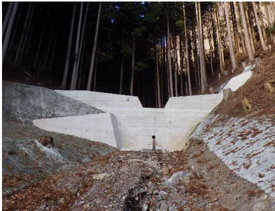
令和元年完成 釜石市駒木地区
