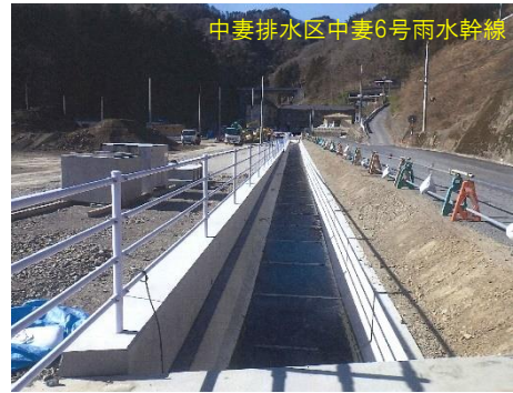
暗渠を開渠化
