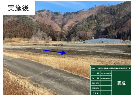
【河道掘削イメージ 令和4年度実施 鵜住居地区】
