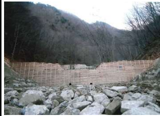
【治山:溪間工(治山ダム)】
