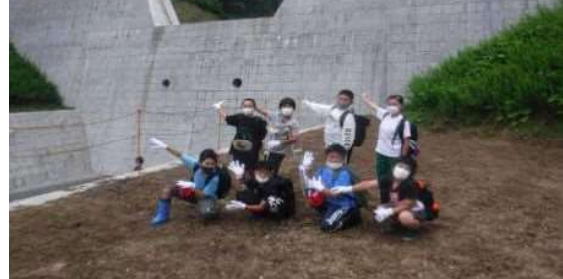
完成した砂防堰堤を見学 (上乙茂の沢(4)砂防堰堤)
