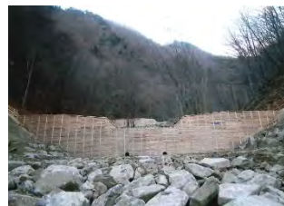
【治山:溪間工(治山ダム)】
