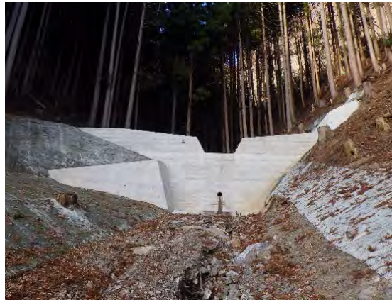
令和元年完成 釜石市駒木地区
