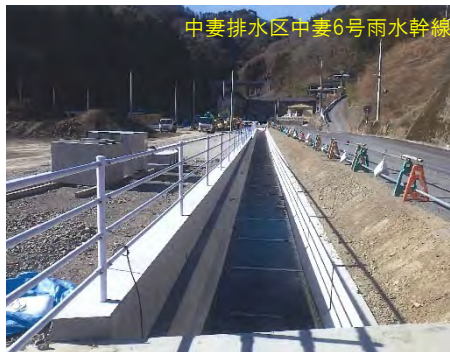
暗渠を開渠化
