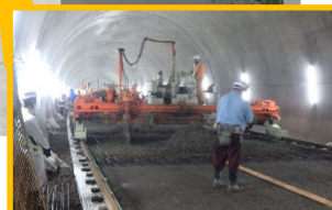
トンネル内のコンクリート舗装の状況
