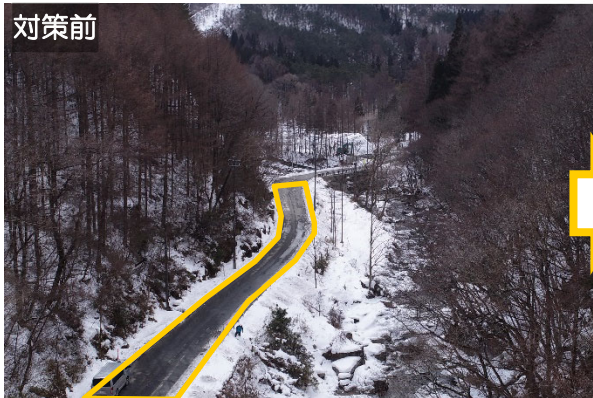
対策状況 (R5.10月撮影)
