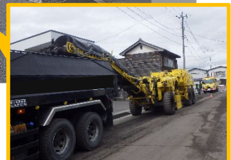
切削（老朽化したアスファルトの削り取り）の状況
