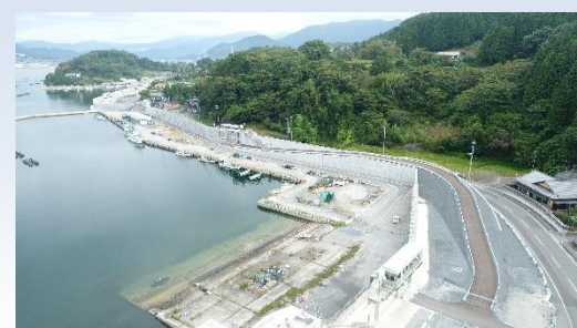
令和 4 年度に完成した 大船渡港海岸清水地区防潮堤（大船渡市）
