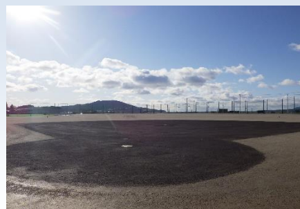
令和元年度に復旧した県立高田高校グラウンド
