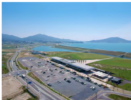
東日本大震災津波伝承館と 高田松原津波復興祈念公園
