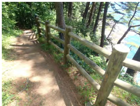
潮吹穴の散策路再整備
