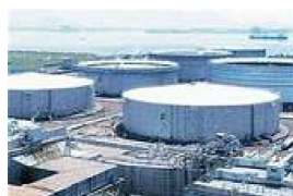
石油貯蔵タンク
