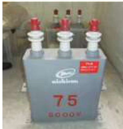
電力用コンデンサー
