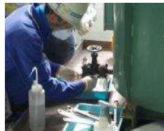
採取口付きの変圧器からの絶縁油の採取
