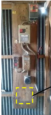
揚水ポンプの分電盤 に設置されていた 低圧コンデンサー
