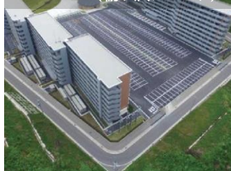
災害公営住宅の整備 (栃ヶ沢アパート)
