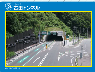
▲8 古田トンネル
