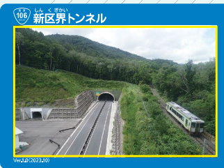
▲11 新区界トンネル
