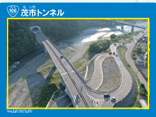
▲6 茂市トンネル
