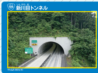
▲15 新川目トンネル
