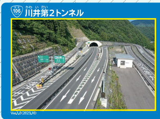
▲9 川井第2トンネル
