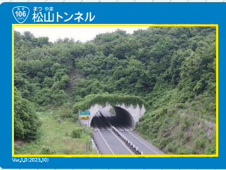
▲3 松山トンネル
