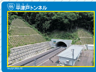
▲10 平津戸トンネル
