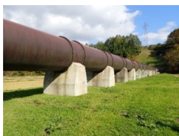
岩洞第二発電所濁川サイフォン
