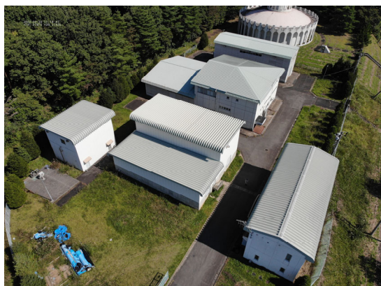
金ヶ崎ろ過施設
