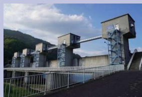
15.5m東北一の高さを誇る普代水門
