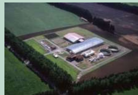
バイオマス発電施設
