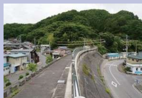
15.5mの太田名部防潮堤
