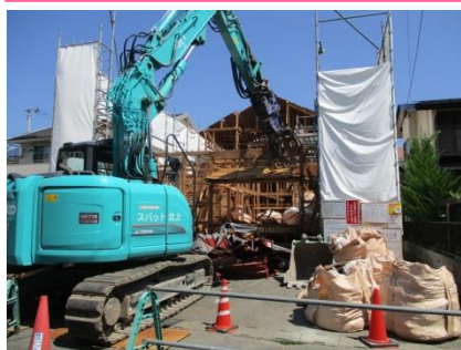
住宅解体工事現場
