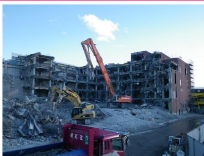
大型施設解体現場
