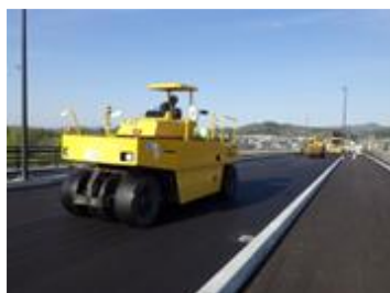
橋面アスファルト舗装
