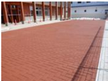
アスファルト景観カラー舗装
