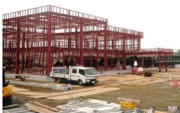
〔建築工事現場〕
