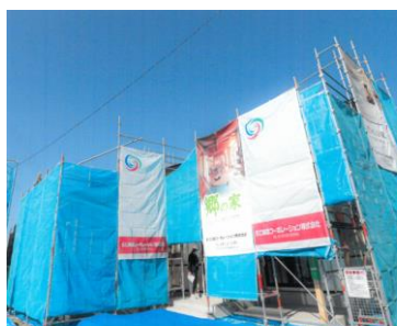
〔住宅工事現場〕
