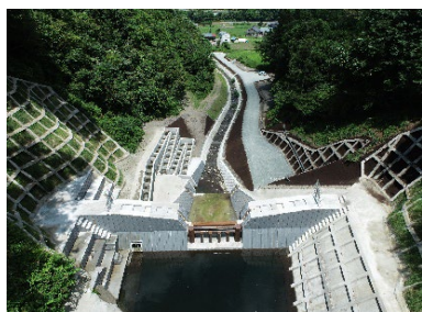
土木工事/成沢砂防堰堤 (住田町)
