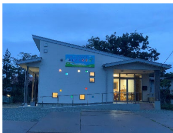
建築工事/あおぞら保育園 (金ヶ崎町)
