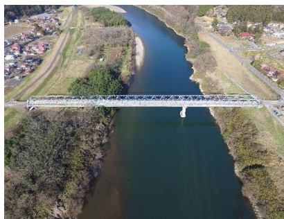
花泉藤沢線北上川 橋梁補修工事
