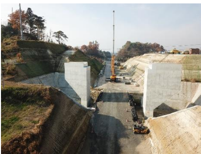
国道 342 号白崖地区道路改良 (その 4) 工事
