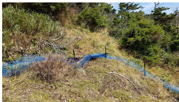
10/24 防護柵 撤去 ※支柱のそのまま、ネットは下で束ねている。
