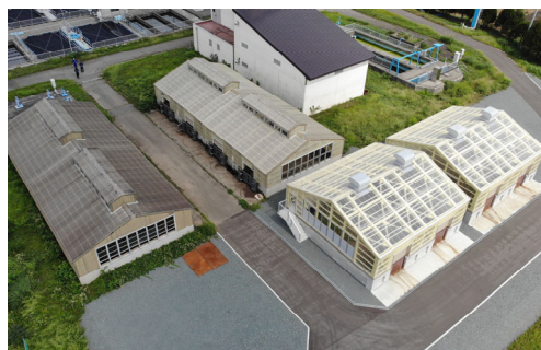
第二浄水場 天日乾燥床
