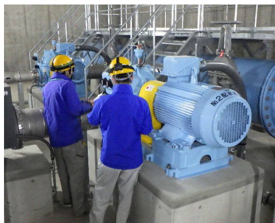
配水ポンプ設備点検の様子
