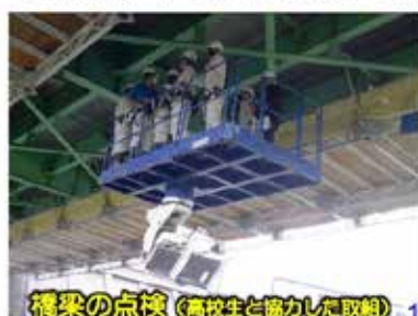
橋梁の点検 (高校生と協力した取組) 19
