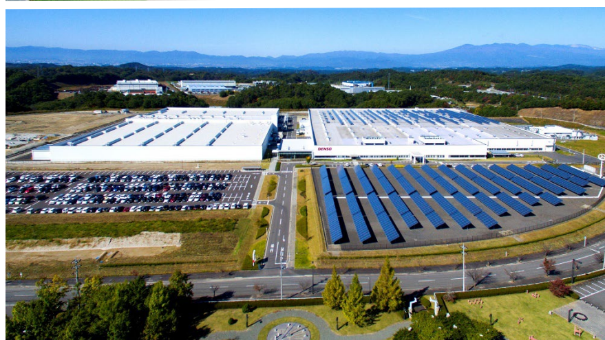
上：デンソー福島工場に設置した水電解装置 下：デンソー福島工場全景（太陽光発電の電力にて水素製造）
