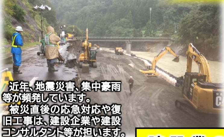
崩壊した道路の応急復旧 ～平成28年台風災害時(岩泉町)
