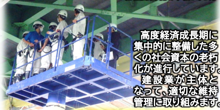
橋梁点検(高校生とともに) ～花巻農業高校、令和5年9月
