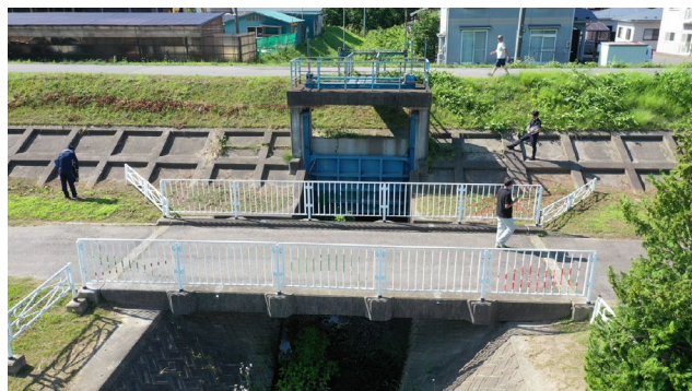
築堤及び樋門を撮影
