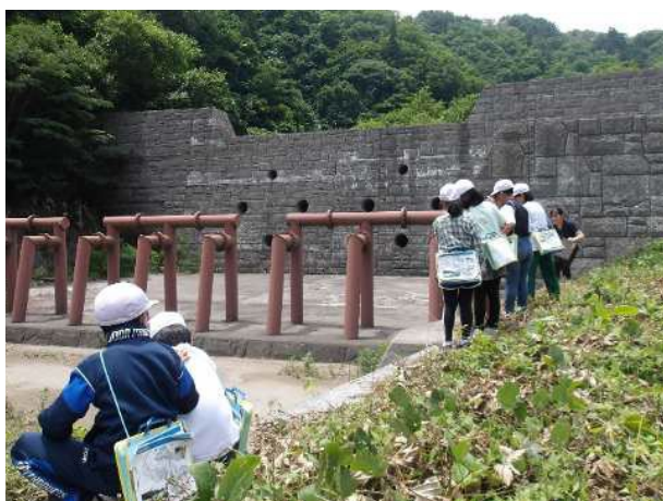
小学校の近くにある砂防堰堤を見学！
