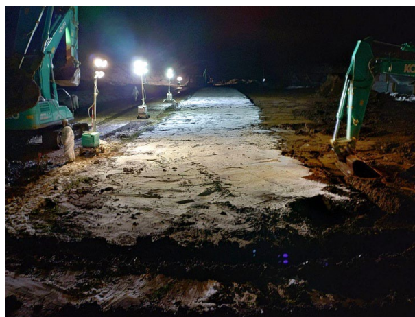
④ 埋却作業完了
