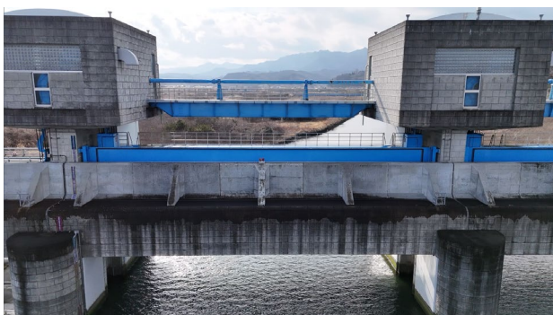
みお筋上空カーテンウォール、支柱
