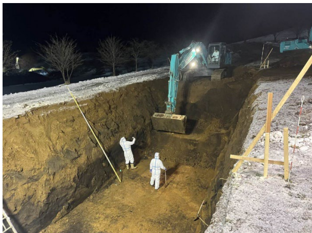
① 埋却溝の掘削
