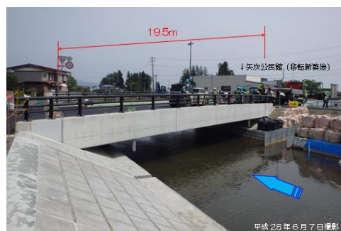
完成した岩崎川橋（新橋）
