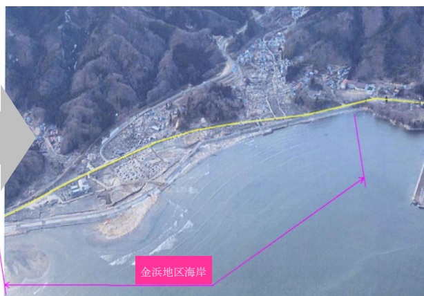
被災後（平成23年3月）
