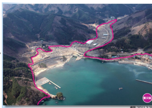
被災後（平成 23 年 3 月）
