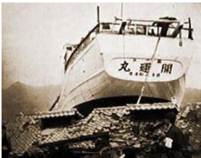
昭和35年千り地震津波の被害状況（大船渡市盛町）
