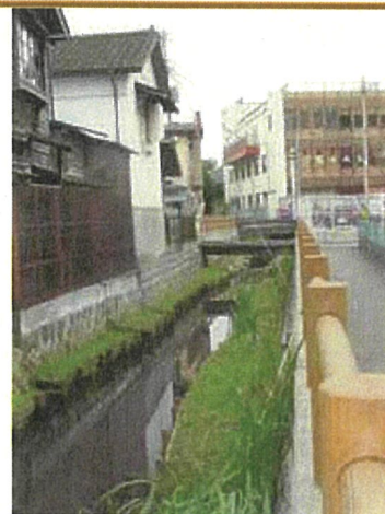
山口川浸水対策事業（宮古市）
