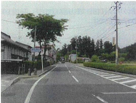
整備前（平成 15 年）
