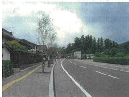
整備後（平成 19 年 8 月）
