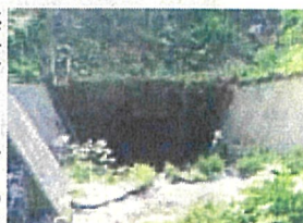
国道106号 動物横断路 (盛岡市築川地区)
