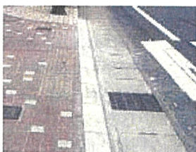
国道284号 段差解消 (一関市大町地区)
