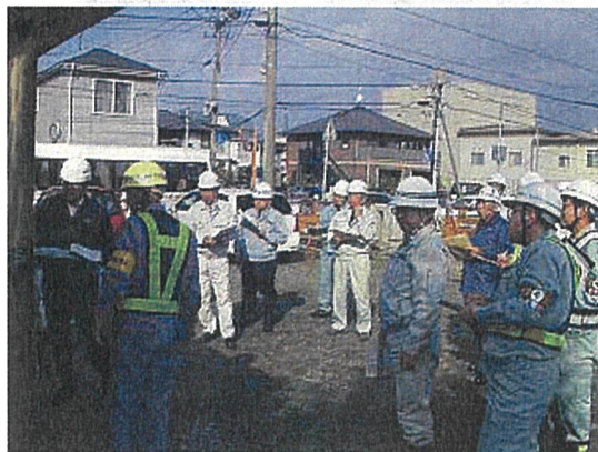
安全点検をするパトロール員
