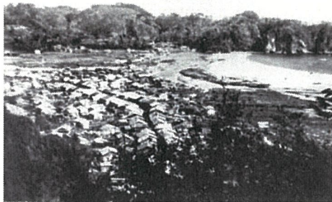
昭和 8 年三陸津波 発生前
