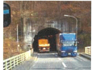
国道281号(久慈市鰻淵トンネル)
