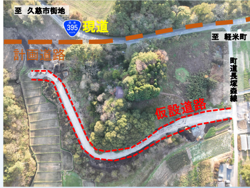
▼航空写真②（仮設道路設置状況）
