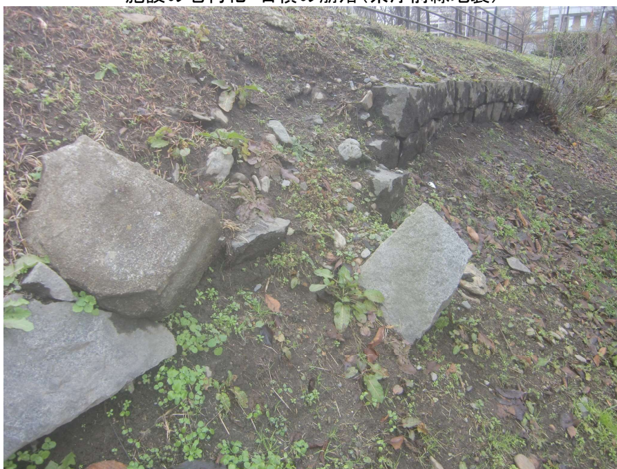
施設の老朽化・石積の崩落(県庁前緑地裏)
