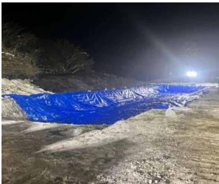
埋却溝へのブルーシート敷設
